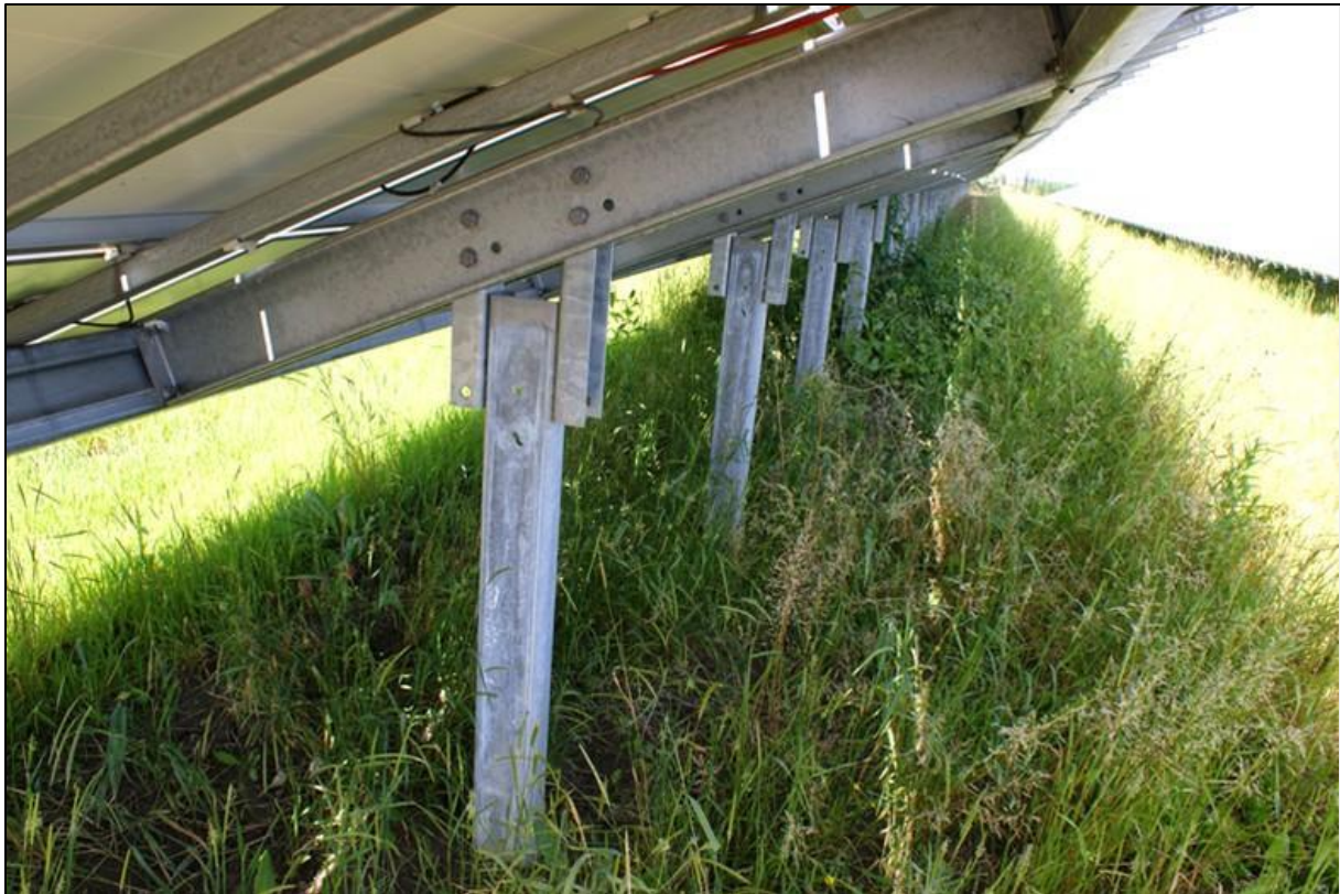
Rysunek 11. Sposób łączenia szkieletu-podstawy modułów fotowoltaicznych z profilami.
