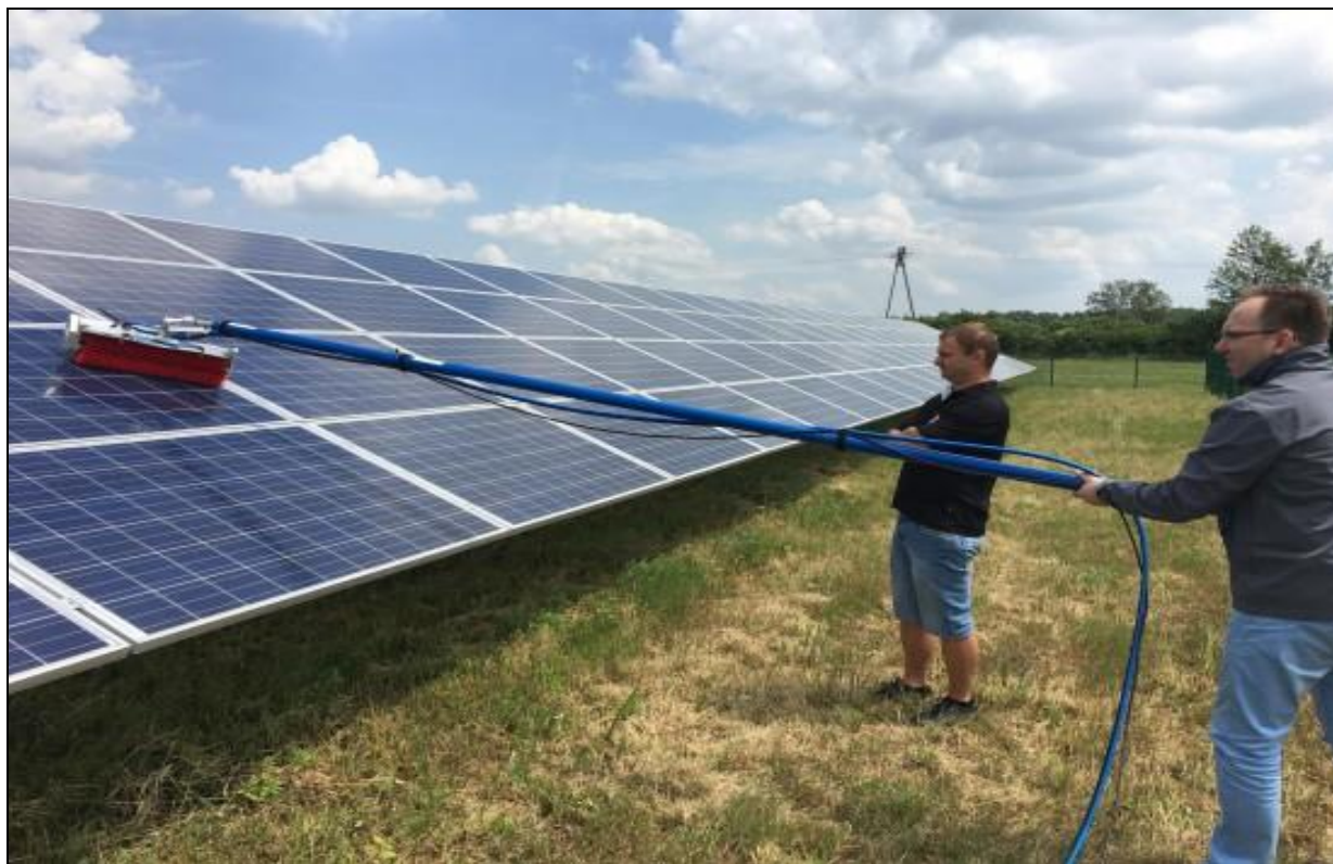
Rysunek 18. Przykładowy sposób ręcznego mycia paneli fotowoltaicznych.
