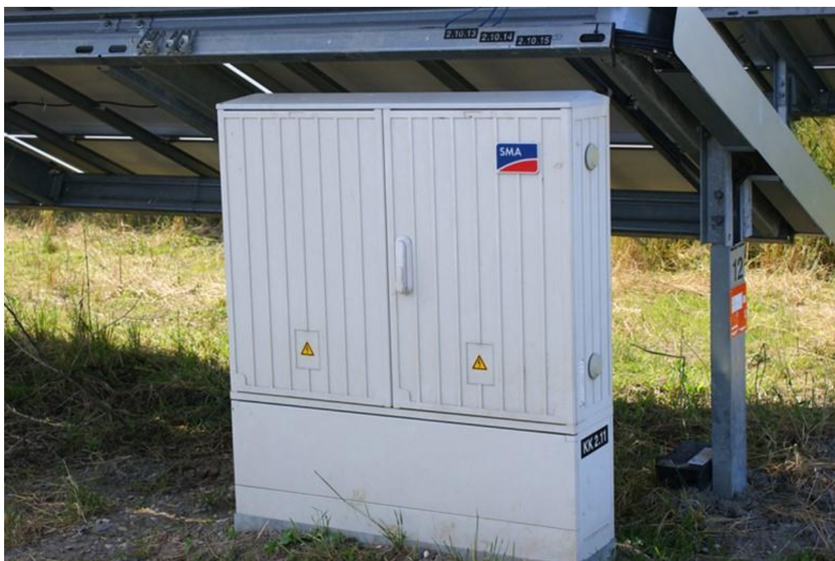
Rysunek 13. String-box mocowany na gruncie
