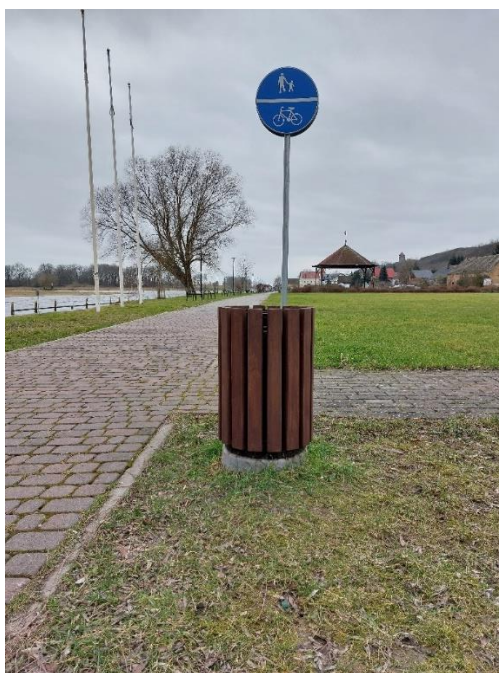
Remont śmietników drewnianych na Promenadzie w Santoku
