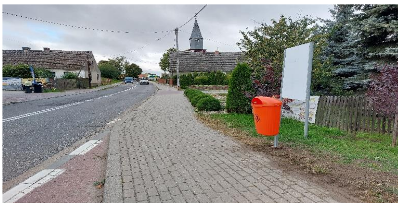
Montaż nowych koszy ulicznych
