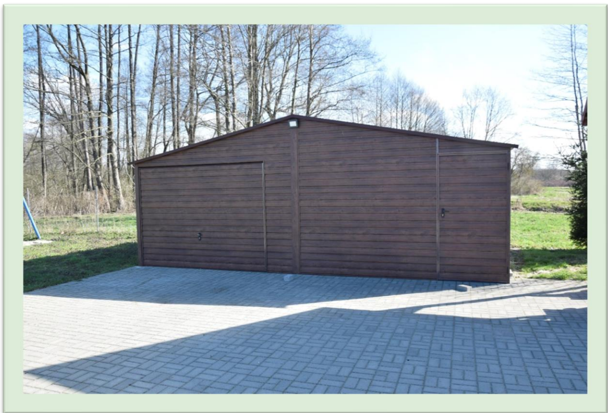
Baranowice – wykonanie podbudowy pod garaż
