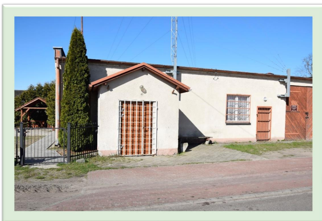
Ludzisławice – wykonanie utwardzenia terenu przy sali wiejskiej
