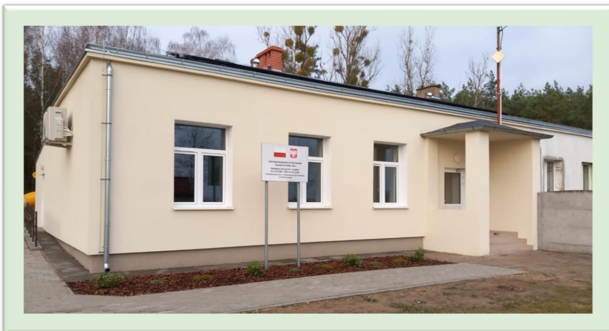
Płomykowo – Remont sali wiejskiej
