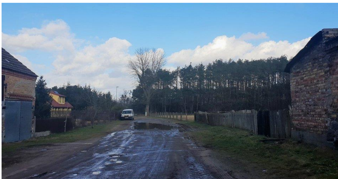
ul. Skwierzyńska w Starym Polichnie (przed przebudową)
