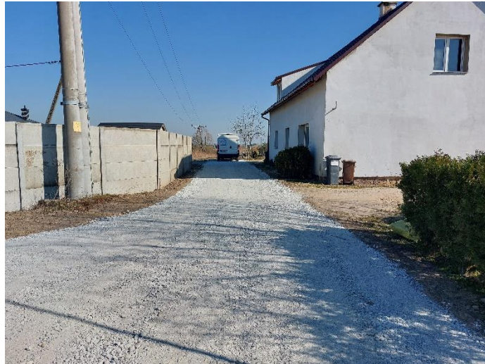
Remonty cząstkowe dróg gminnych o nawierzchni bitumicznej
