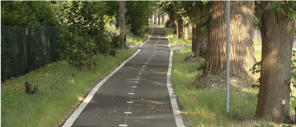
Zdjęcie 15. Droga rowerowa w ciągu ul. Szczecińskiej w Gorzowie Wielkopolskim
