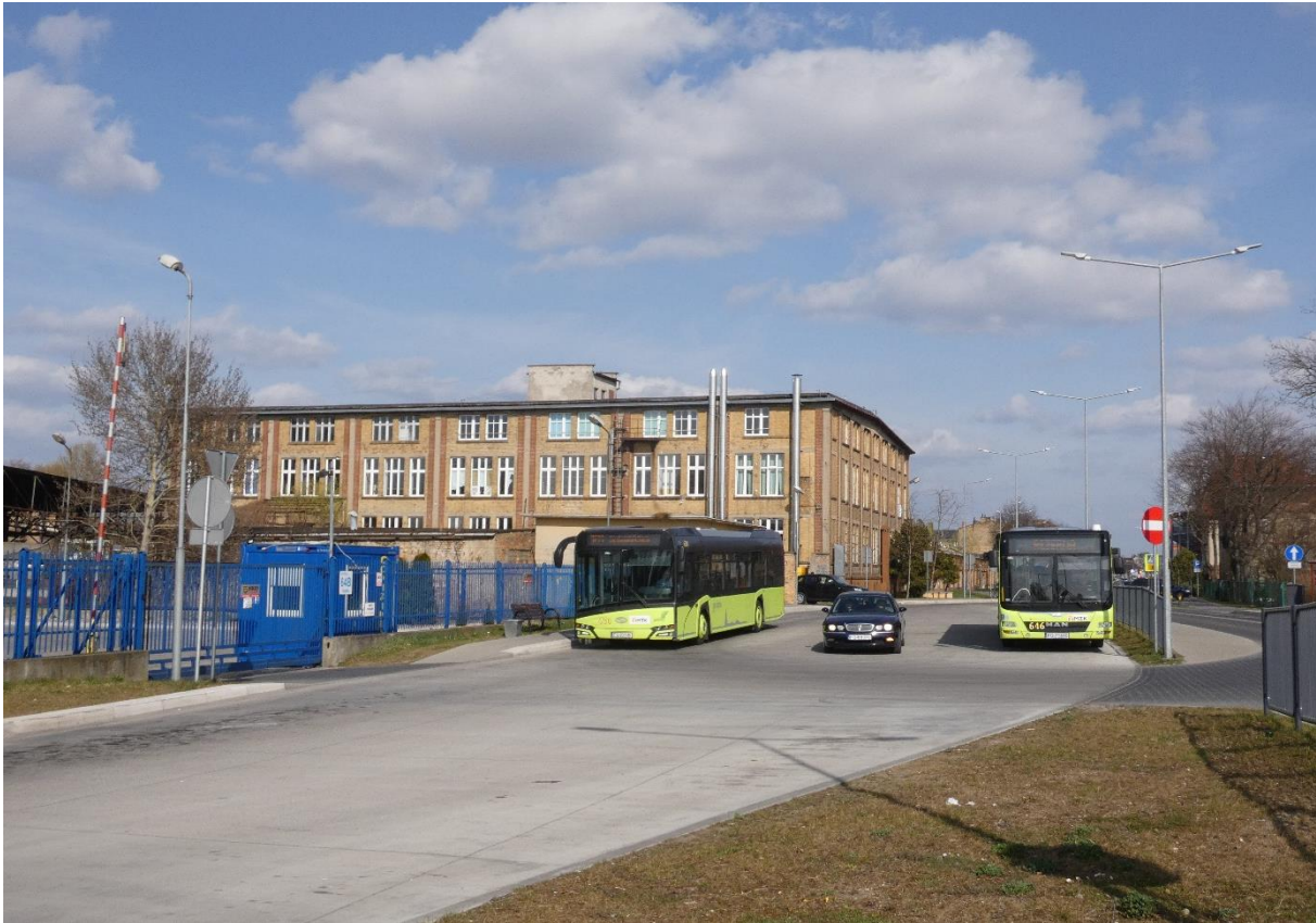
Zdjęcie 30. Pętla Śląska – Pole Golfowe. Widok na stanowiska postojowe dla autobusów
